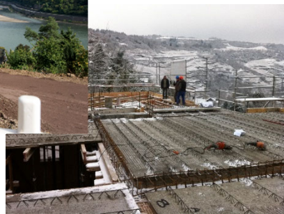
Bauarbeiten, Stand: 30.11.2010 (Foto: Herbert Steffen)
