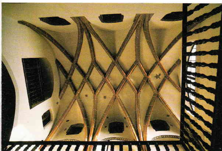
Kleinod der Renaissance: Netzrippengewölbe einer Zentralhalle am Untermarkt
